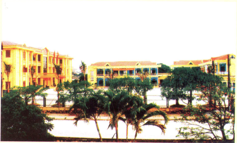
Trụ sở làm việc của Huyện uỷ Duy Tiên xây dựng năm 1990 hàng năm đều được tu sửa nâng cấp.
